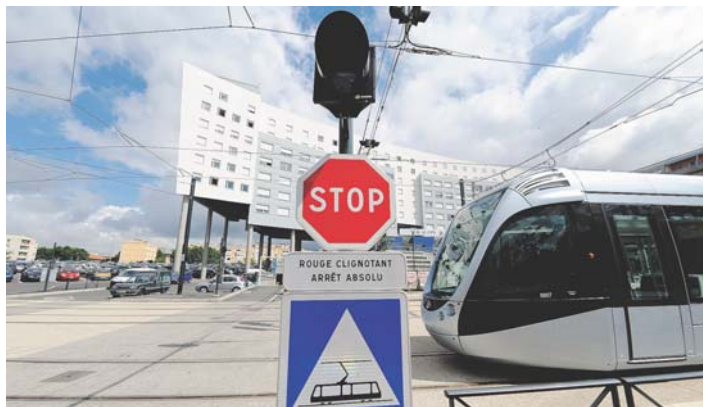
Le chantier du tramway de Toulouse a été attribué à la société ibérique Comsa. X. DE FENOY/LA DEPECHE DU MIDI
